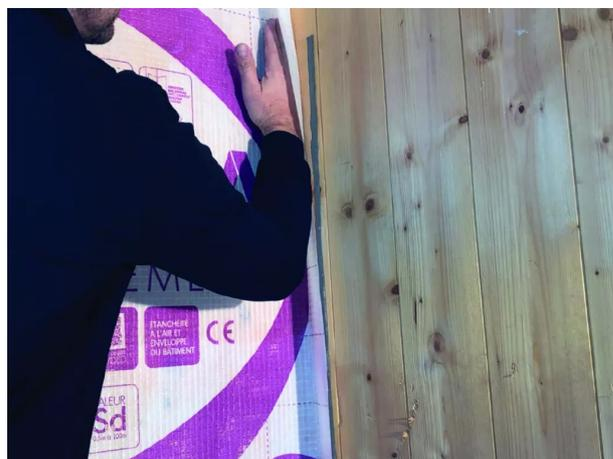
Peut être utilisé pour le collage de membranes sous-toiture, pare-pluie et pare-vapeur sur divers types de matériaux de construction de maçonnerie (enduit, béton, bois, métal, acier, aluminium, PVC, polycarbonate, verre, etc).
