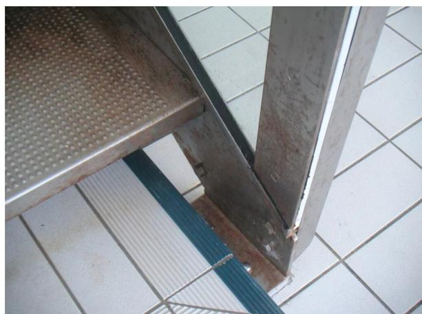
S'utilise par procédé de trempage, pulvérisation et par application manuelle au pinceau ou balai. Supprime la rouille superficielle et atténue certaines irrégularités sur la surface de l'acier inoxydable. Ne ternie pas les surfaces brillantes (exemple : polissage, brossage, ponçage).
