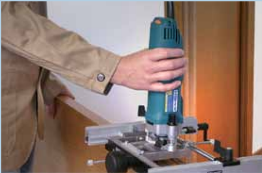
Entaillage sur l'ouvrant, 1 ère paumelle.
